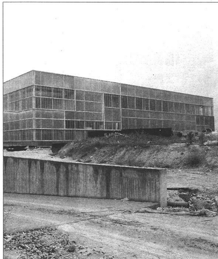
Aunque las obras están casi concluidas ahora es preciso iniciar la equipación.
